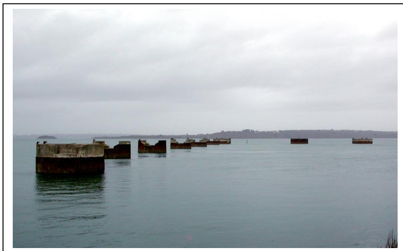
Gabions et ducs d'albe de Lanvéoc
